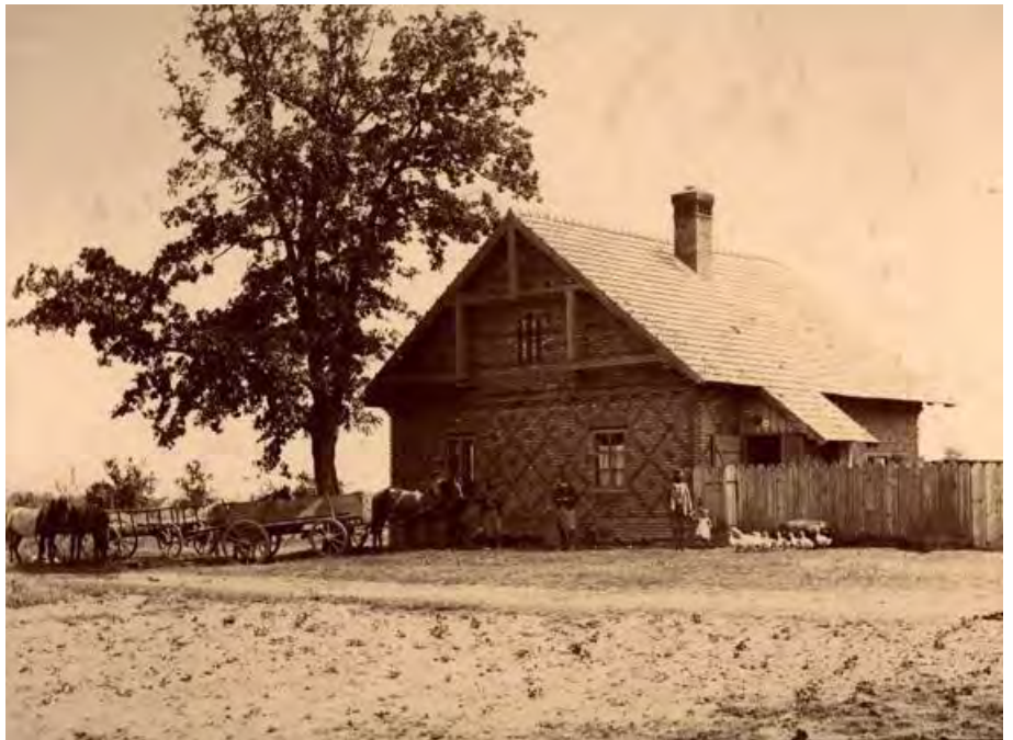
Vlašic Hegerhaus Umbauarbeiten (nach 1900 ?)
