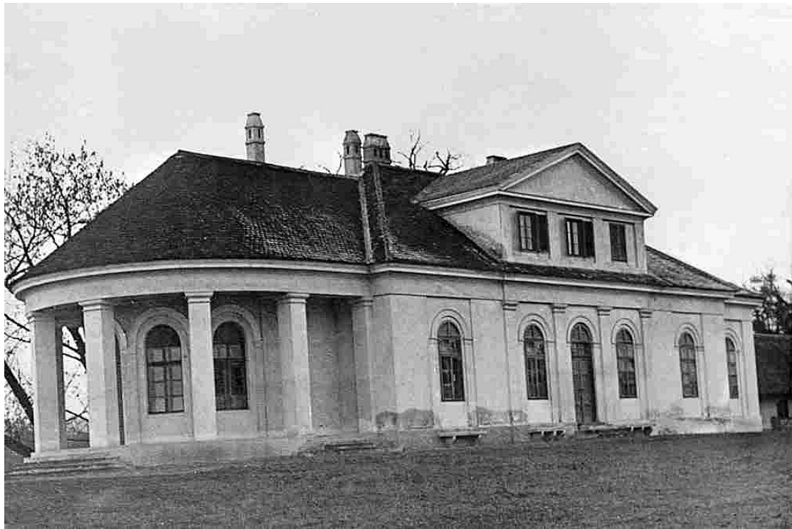
Jagdschlössl „Auf den Lahren“ Umbauarbeiten 1. Stock und halbkreisförmige Apsis (1911/18)
