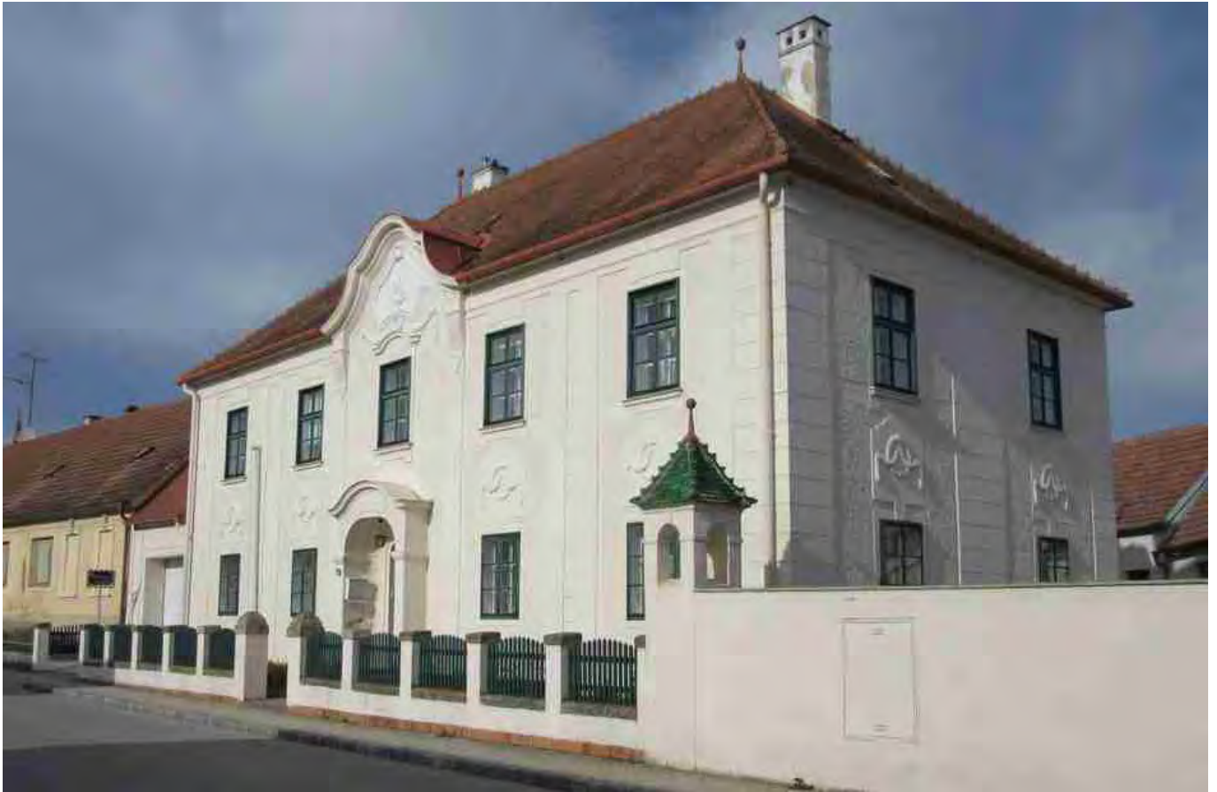
Umbauarbeiten am Pfarrhof
